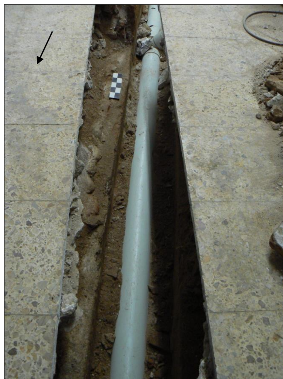
Fig. 9: Detall rasa claveguera.
