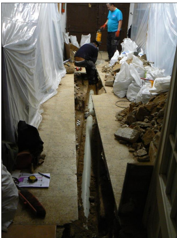
Fig. 8: Vista general claveguera.
